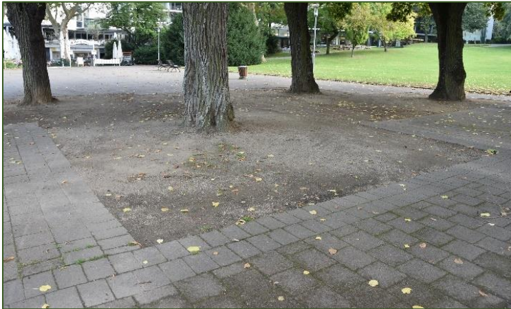
Abb. 271 Ausgesparter Pflasterplattenbelag mit alten Linden im westlichen Terrassenbereich
