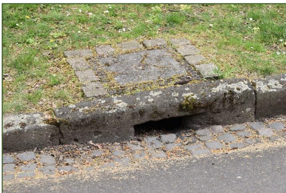
Abb. 182 Bord- und Entwässerungsstein mit Basaltkleinpflasterrinne
