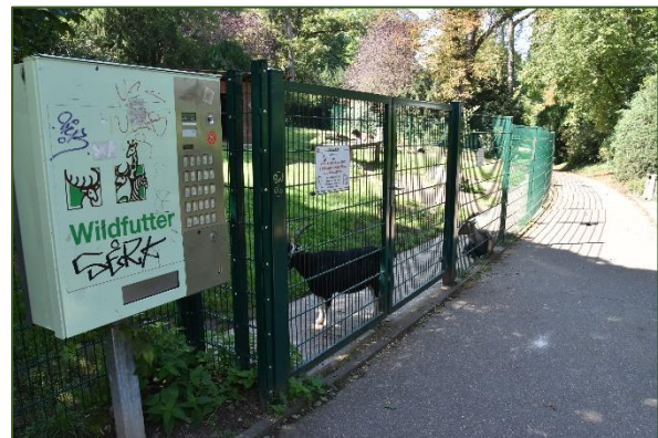
Abb. 75 Drahtgitterzaun aus Einzelfeldern mit Rundrohrrahmen aus den 1960er Jahren und Kniegitter aus den 1970ern
