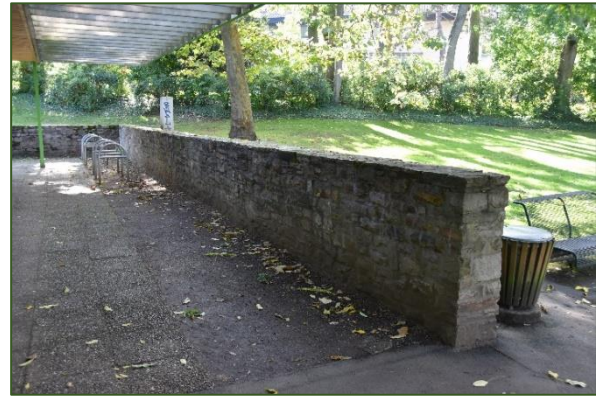
Abb. 300 Natursteinmauer und Waschbetonplatten am Vogelhaus, fehlender Plattenbelag bei den Fahrradständern an der Westseite der Hofgestaltung
