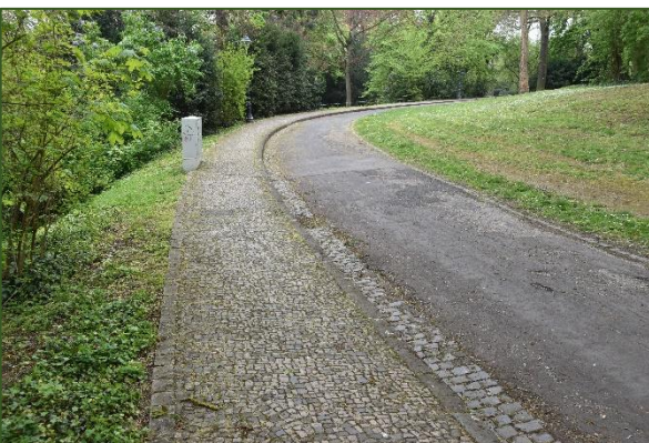
Abb. 184 Gehweg aus Mosaikpflaster im nördlichen Bereich der Abtsgasse
