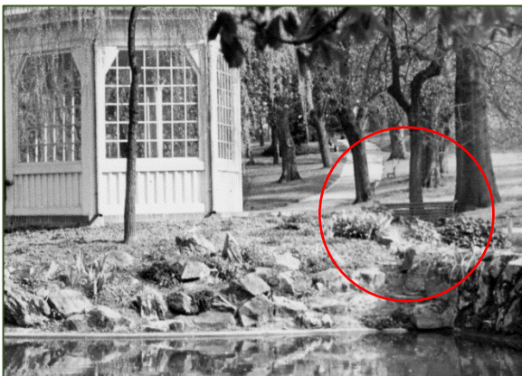
Abb. 77 Bank aus durchgehender Horizontallattung am Hauptweg, um 1950
