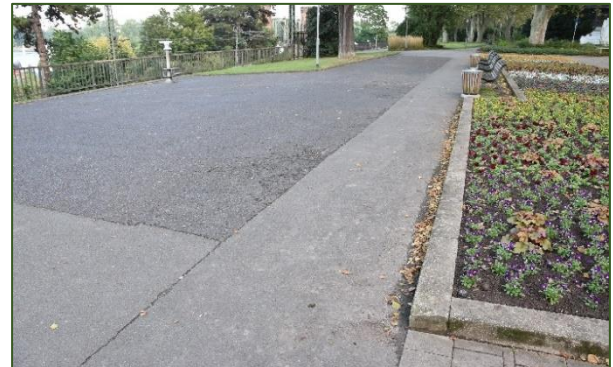
Abb. 273, 274 Geflickter Asphaltbelag am Hotel und an der Terrasse
