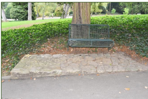
Abb. 222a Sitznische am oberen Bogenweg mit Befestigung aus Polygon-Natursteinen
