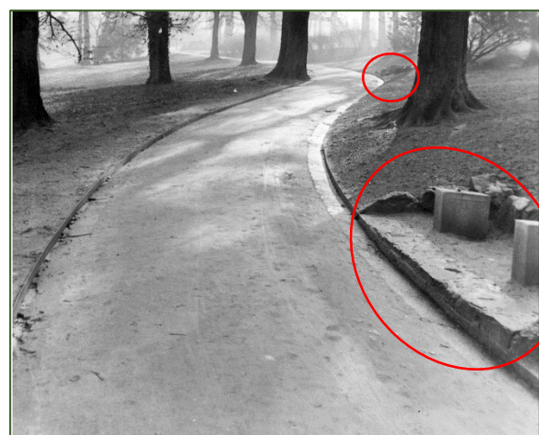
Abb. 221 Oberer Bogenweg, wassergebundene Wegedecke, Entwässerungsrinne aus schmalen Betonplatten und Kantenstein, Sitznischen mit Bänken mit Betonfüßen und Holzauflagen, 1950er Jahre
