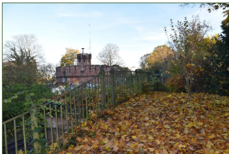
Abb. 226: Trampelpfad oberhalb der Bahngleise zum ehemaligen Brückenkopf
