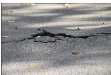
Abb. 297-299 Schadhafte Asphaltdecken, Westseite Vogelhaus
