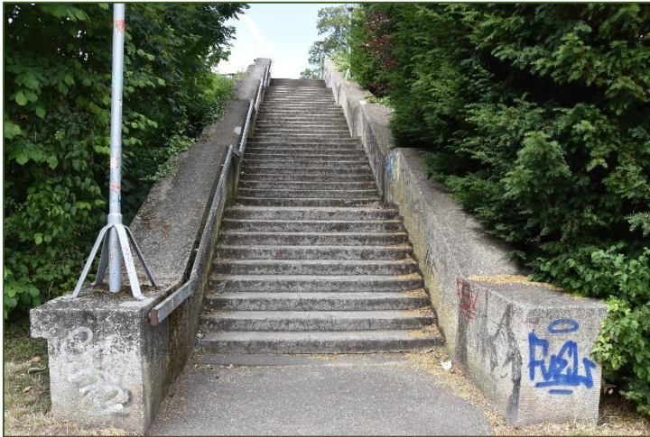
Abb. 347, 347a Treppenaufgang zur Fußgängerbrücke, unsachgemäße Reparatur an den Treppenwangen, kaum erkennbar die Scharrierungen im Beton
