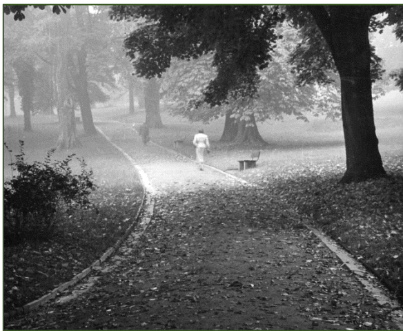
Abb. 221 Oberer Bogenweg, wassergebundene Wegedecke, Entwässerungsrinne aus schmalen Betonplatten und Kantenstein, Sitznischen mit Bänken mit Betonfüßen und Holzauflagen, 1950er Jahre
