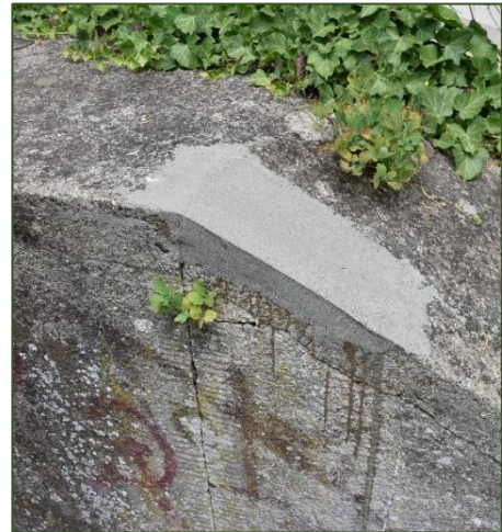
Abb. 347, 347a Treppenaufgang zur Fußgängerbrücke, unsachgemäße Reparatur an den Treppenwangen, kaum erkennbar die Scharrierungen im Beton
