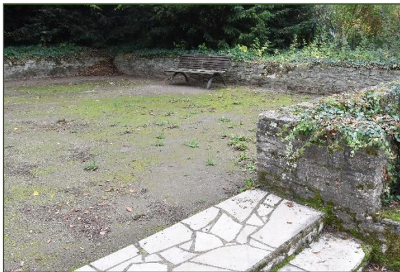
Abb. 143 Vergrünte und sanierungsbedürftige Deckschicht im Rosenhof - Zugang über 2015 erneuerte Kalksteinstufen
