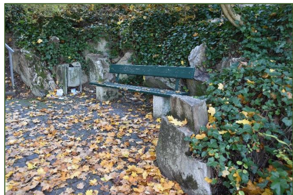
Abb. 180, 180a Sitzplatz aus Balsaltkleinpflaster, gerahmt von punktuell mangelhaft standfesten Felssteinen
