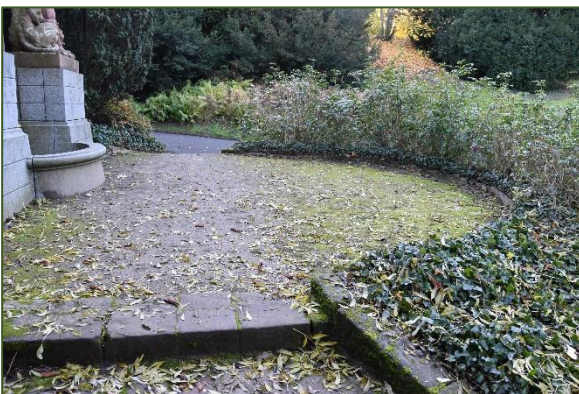
Abb. 30, 31 Wassergebundener Vorplatz am Schützenbrunnen mit Einfassung aus Betonplatten
