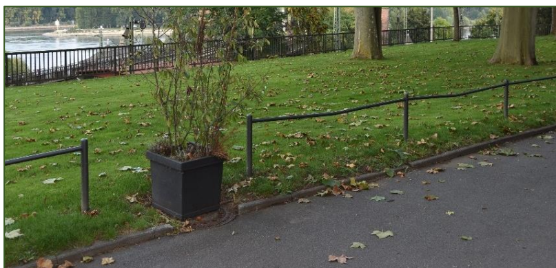
Abb. 292 Funktionsloses Kniegitter entlang der Rasenfläche an Nordseite Parkhotel
