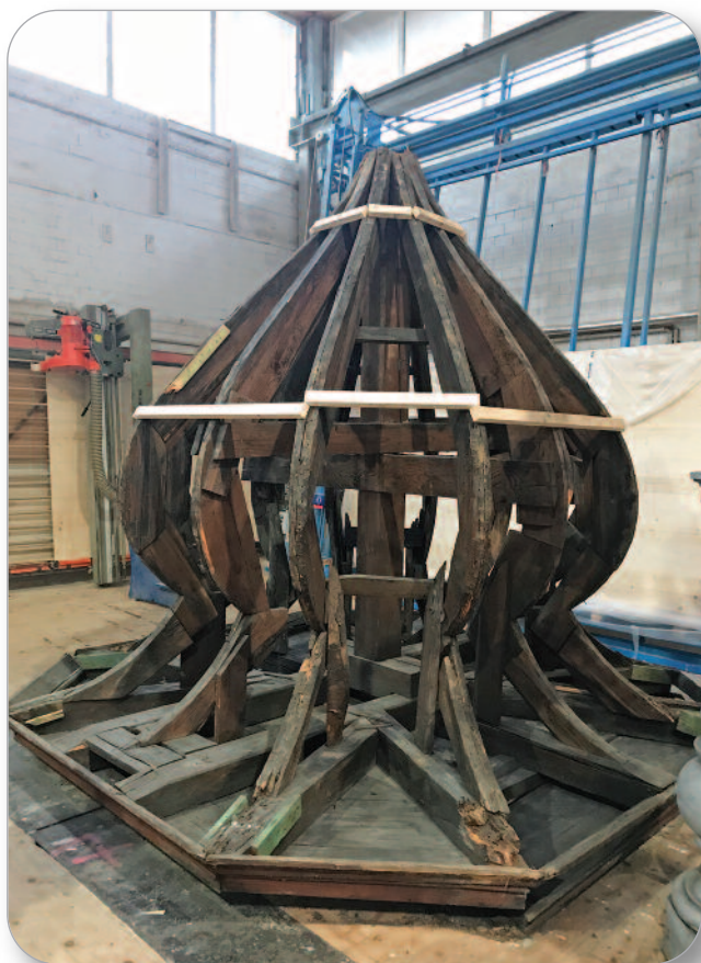
Das hölzerne Grundgerüst des Glockenturms der Eisgrubschule wird in traditioneller Zimmermannstechnik instandgesetzt.
