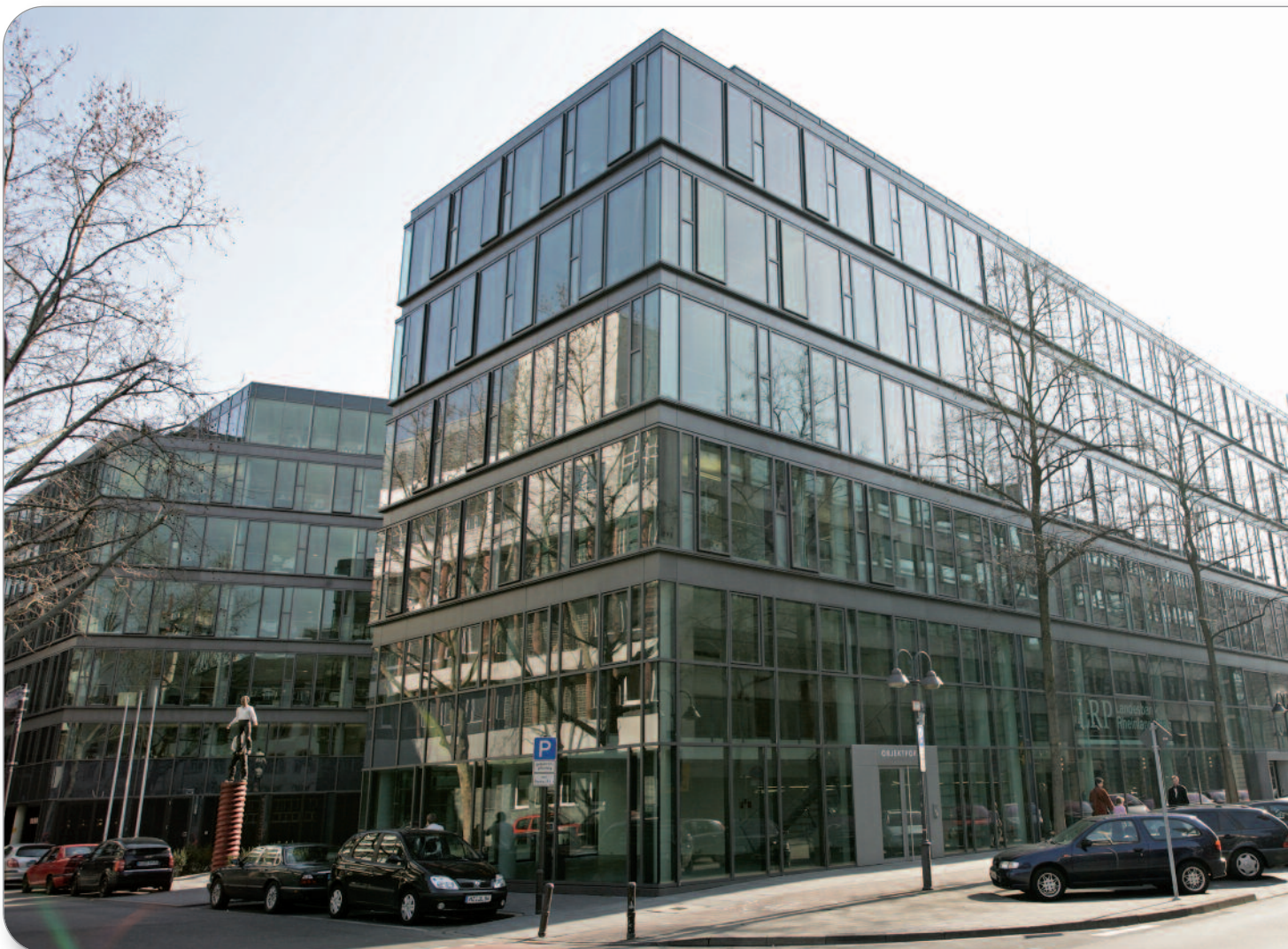
Ausweichquartier fürs Rathaus: Während der Sanierung sind die Mitarbeiterinnen und Mitarbeiter im neuen Stadthaus Große Bleiche untergebracht.
