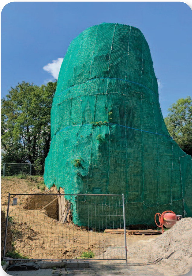
Zum Schutz der Arbeiter, die das Umfeld gestalten, wurde der Drususstein in ein Schutznetz eingepackt.
