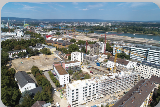
Baustelle Wallastraße in der Mainzer Neustadt. Das Foto wurde 2018 aufgenommen – inzwischen ist der Bau des Gebäudes weiter fortgeschritten.
