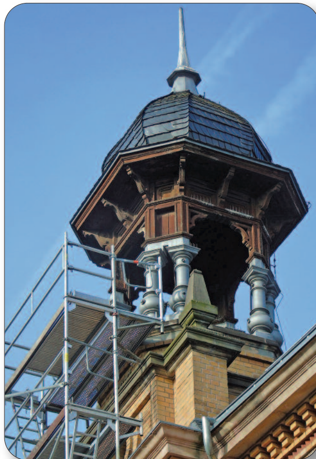
Restaurierungsarbeiten am Glockenturm der Eisgrubschule.
